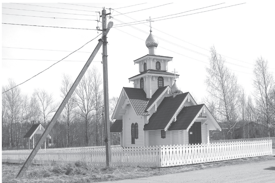
Рис. 3. Церковь в пос. Кондратьево Выборгского р-на Ленинградской обл. Фото автора
