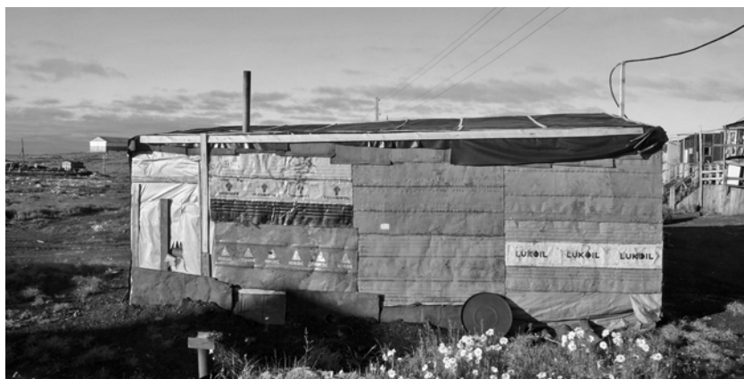
Рис. 7. Использование в строительстве железных листов, изготовленных из бочек. Новорыбное. Июль 2015 г. Фото автора
