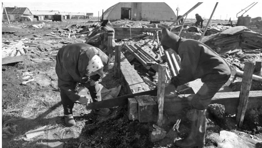
Рис. 4. Демонтаж здания. Новорыбное. Июль 2015 г. Фото автора
