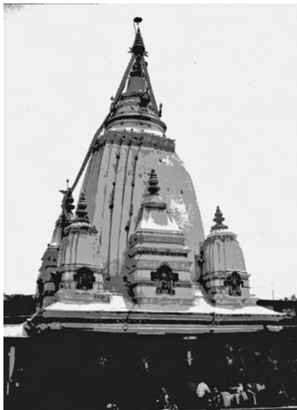
Рис. 4. Храм Красного Мачхендранатха. Бунгамати. Разрушен во время землетрясения в апреле 2015 г. Фото автора
