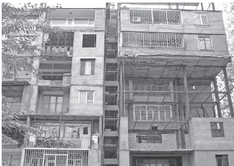
Пристройки к жилому дому
